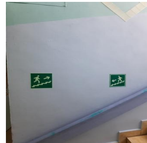
Фото №12 Визуальные средства путей эвакуации
