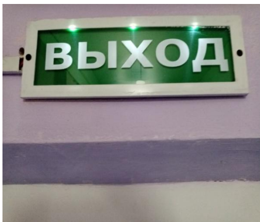
Фото № 11 Визуальные средства путей эвакуации
