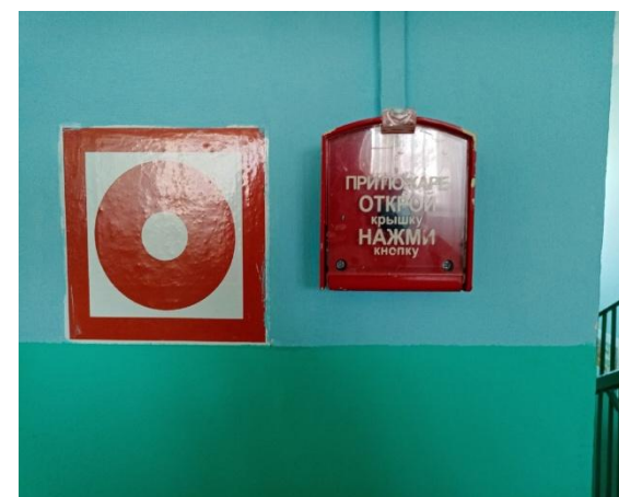
Фото №14 Визуальные средства путей эвакуации
