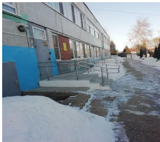
Фото №3 Навес, водоотвод, крыльцо ,лестница наружная, пандус наружный.
