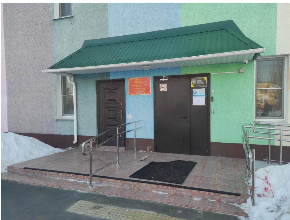
Фото №3 Навес, водоотвод, крыльцо, лестница наружная
