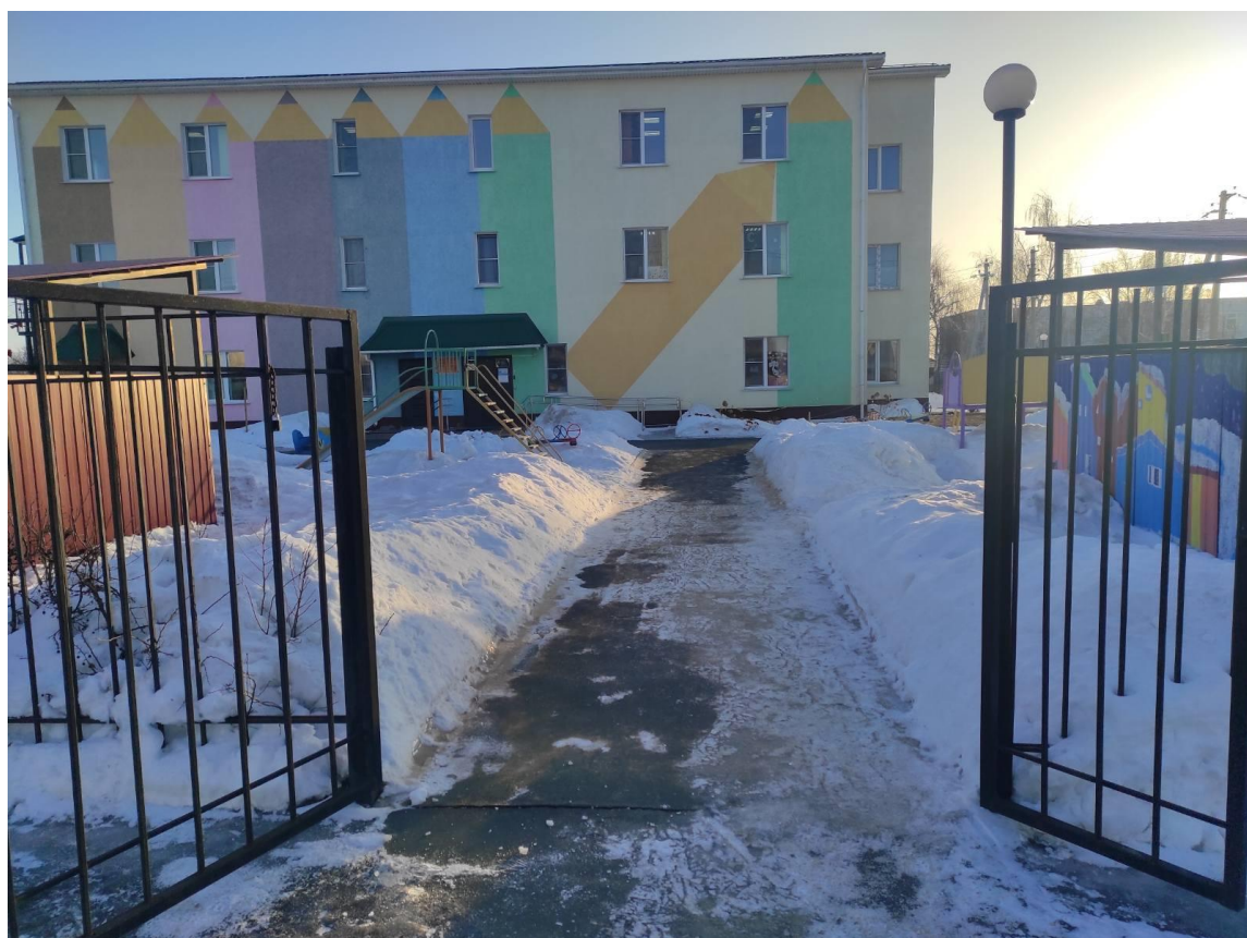
Фото №2 Путь к главному входу
