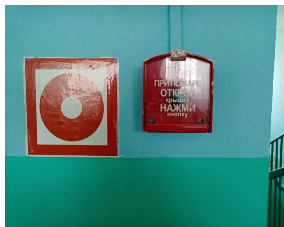
Фото №16 Визуальные средства путей эвакуации
