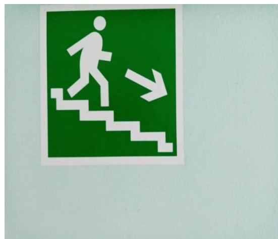
Фото №14 Визуальные средства путей эвакуации
