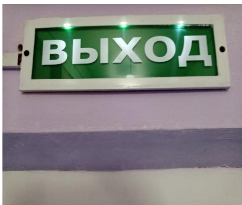
Фото № 13 Визуальные средства путей эвакуации
