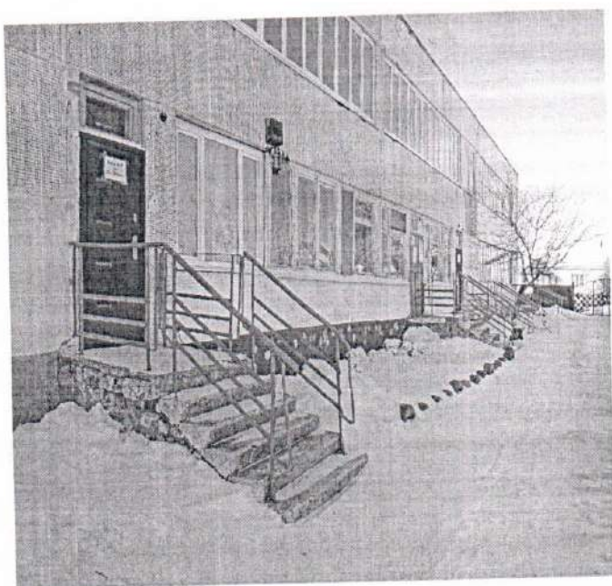
Фото №3 Навес, водоотвод, крыльцо, лестница наружная, пандус наружный, звуковой маяк у входа
